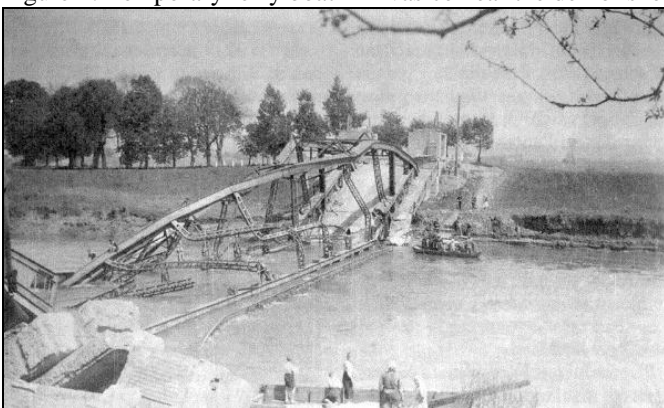
Obr. 4: Dočasný prívoz v Kvasicích u zboženého mostu v roce 1945 Figure 4: Temporary ferry boat in Kvasice near the demolished bridge in 1945
