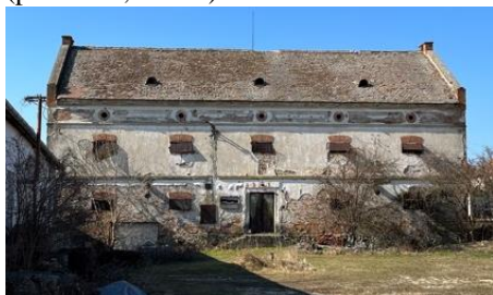
Obr. 4: Bývalá sýpka v obci Šurianky (plocha: 0,034 ha)
