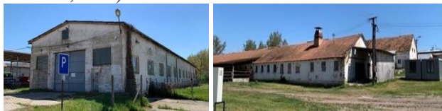
Obr. 13: Bývalý hospodársky areál v obci Rumanová (hospodárske budovy, plocha areálu: 5,67 ha)
