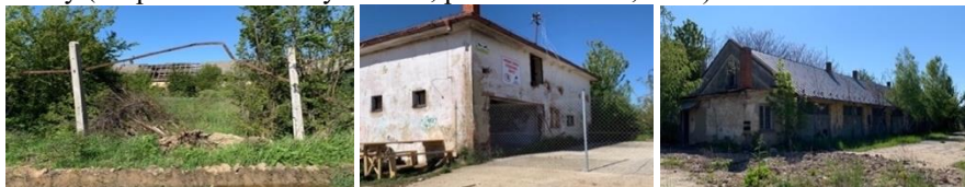
Obr. 12: Areál bývalého poľnohospodárskeho družstva v obci Lehota, časť Krvavé Šenky (hospodárske budovy + sklad, plocha areálu: 4,70 ha)
